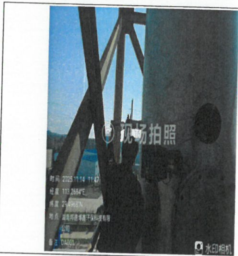
附图 1 有组织废气排气筒出口 DA001
